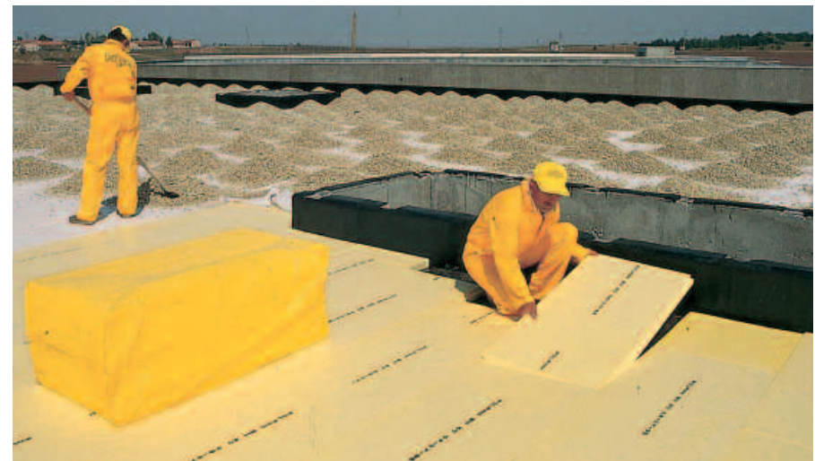
Ters Teras Çatılarda Membran
